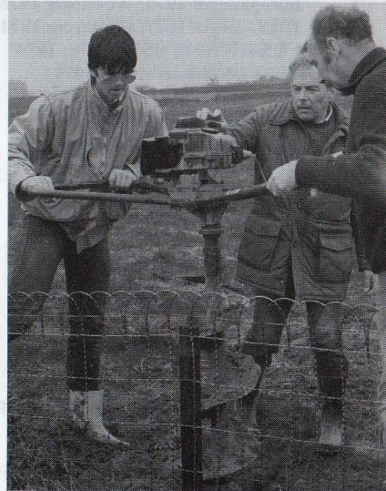
Installation der Galgen: Erdbohrer mit (zeitweise) „fliegendem“ Personal (v.l.: P. Marklein, Erdbohrer, E. Hubmann, P. Vogt)
