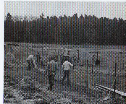
Erdarbeiten zur Verkabelung
